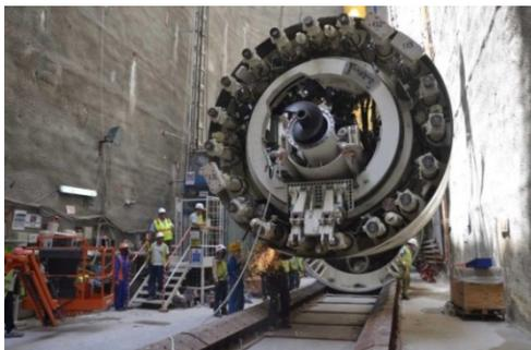
Baustellenmontage der Herrenknecht Tunnelbohrmaschine, die als erste TBM in Katar im Segmental Lining Verfahren einen Tunnel auffährt. Außer den zwei Maschinen für das Abwasserprojekt Abu Hamour Southern Outfall werden in dem Emirat weitere 21 Herrenknecht EPB-Schilde für den Bau der Doha Metro im Einsatz sein.
