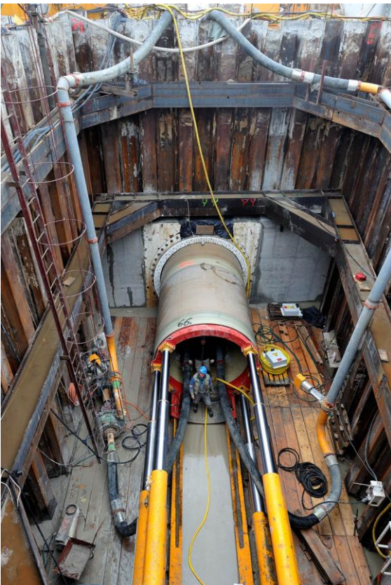
Die Baustellenteams realisierten im Pipe-Jacking-Verfahren insgesamt 16 bis zu 930 Meter lange Teilstrecken.
