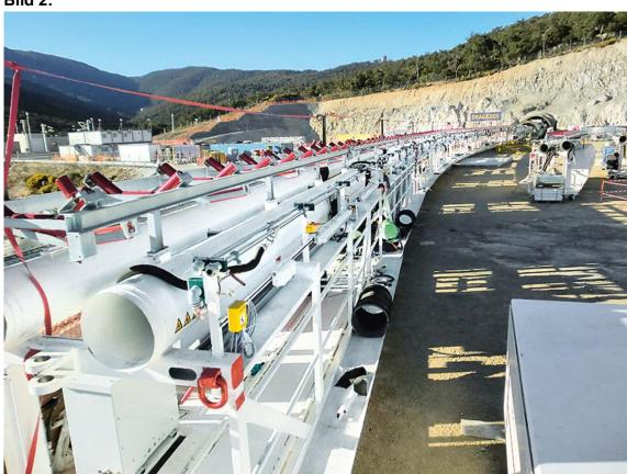
Die Nachläufer der beiden Doppelschild-TBM sind für hohe Vortriebsleistungen darauf ausgelegt, Tübbinge und weiteres Material für zwei Ringbausequenzen zu bevorraten.
