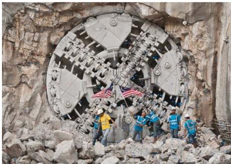
Durchbruch der ersten Variable Density Maschine am 9. Januar 2014: Die eigens für das Klang Valley MRT Projekt entwickelte TBM vereinigt die Vorteile von EPB- und Mixschilden. Die Möglichkeit der Anpassung der Suspensionsdichte im Flüssigkeitsmodus erweitert den möglichen Einsatzbereich und macht die Maschine zu einer universellen Lösung für Lockergestein-Vortriebe aller Art.
