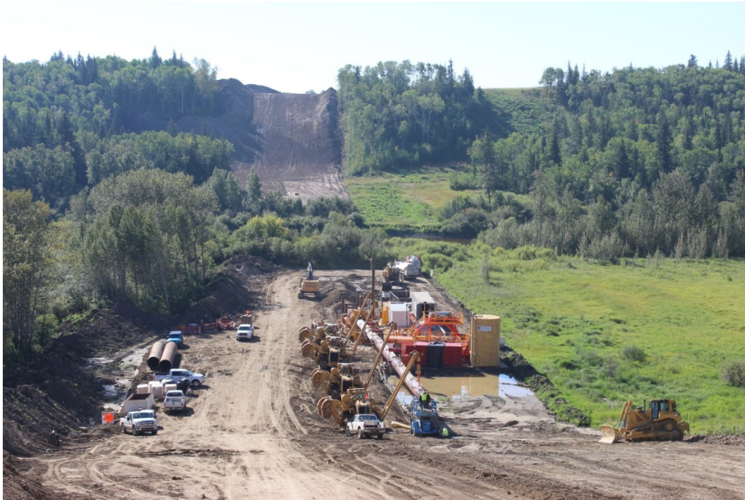
Pic1_ Direct Pipe®-Technologie Premiere in Kanada: in der Provinz Alberta wurde eine Rohrleitung mit einem Durchmesser von 42 Zoll (1.067 mm, doppelte FBE-Beschichtung) über eine Länge von 340 Metern in nur 13 Tagen unter dem Beaver River durchgeführt.
