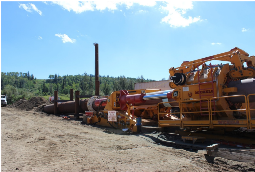
Pic2_ Bei der Direct Pipe®-Technologie von Herrenknecht wird in nur einem Arbeitsschritt eine vorgefertigte Rohrleitung grabenlos installiert und gleichzeitig das dazu erforderliche Bohrloch erstellt. Das sorgt für eine zügige und sehr wirtschaftliche Verlegung von Pipelines mit Längen bis über 1.500 Metern.
