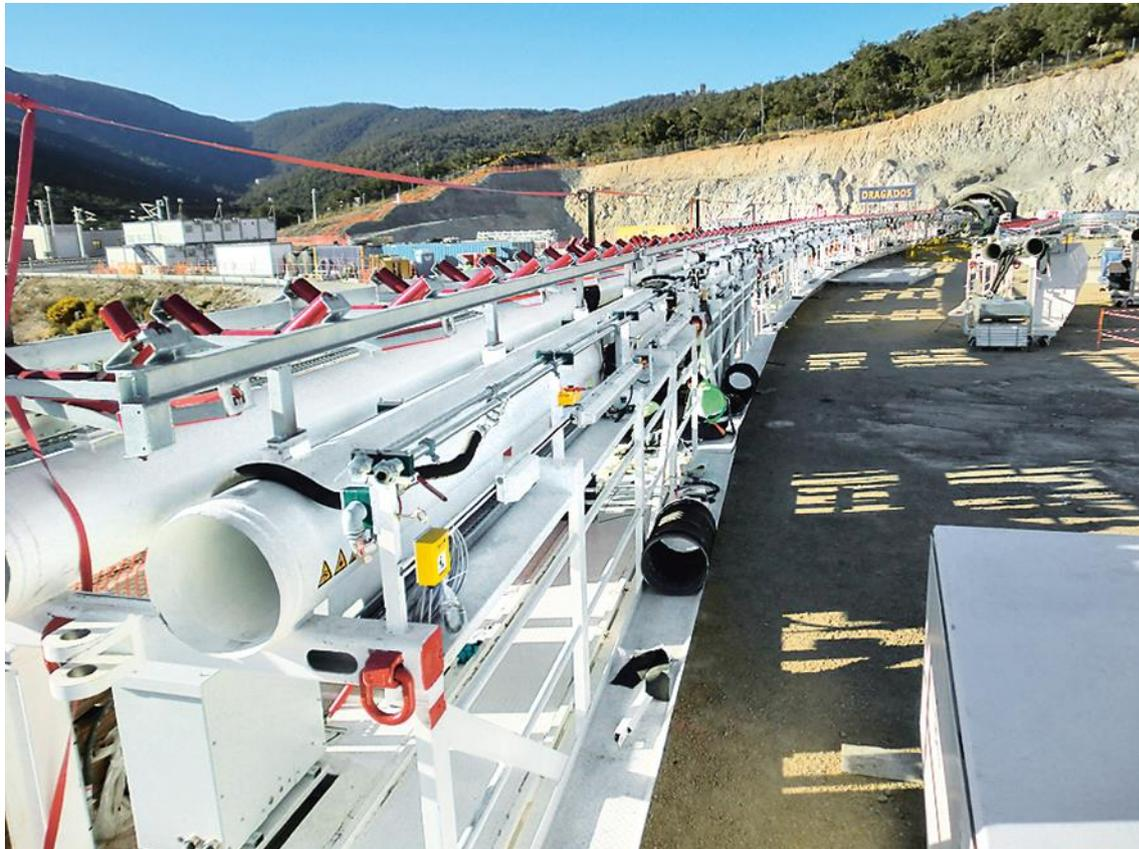
Die Nachläufer der beiden Doppelschild-TBM sind für hohe Vortriebsleistungen darauf ausgelegt, Tübinge und weiteres Material für zwei Ringbausequenzen zu bevorraten.
