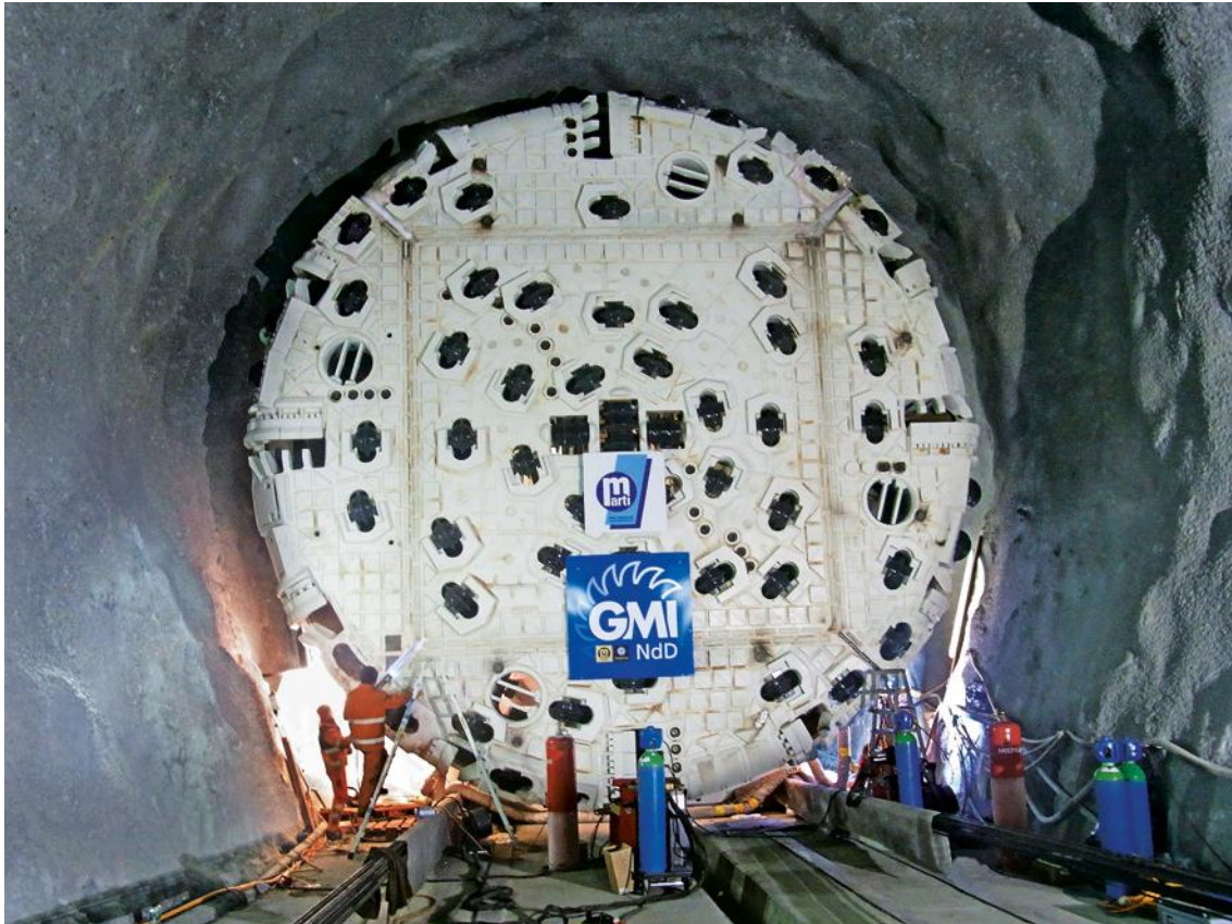
Die Gripper-TBM S-522 (Ø 9.450 mm) in der Startposition für den über fünf Kilometer langen Zugangstunnel.
