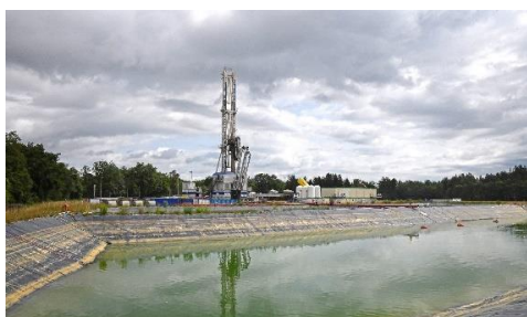
Bild 2 Blick über das Speicherbecken auf den Bohrplatz in Polling.
