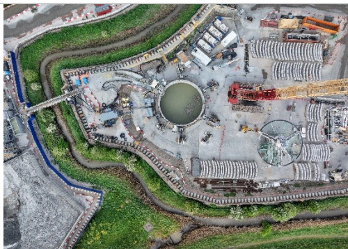
Photo 4 Vertical Shaft Sinking Machine (VSM) während des Baus des Zielschachts für den Themse- Kabeltunnel. (Herrenknecht)
